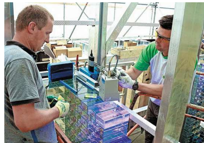
De glazen bakstenen worden aan elkaar gelijmd.
